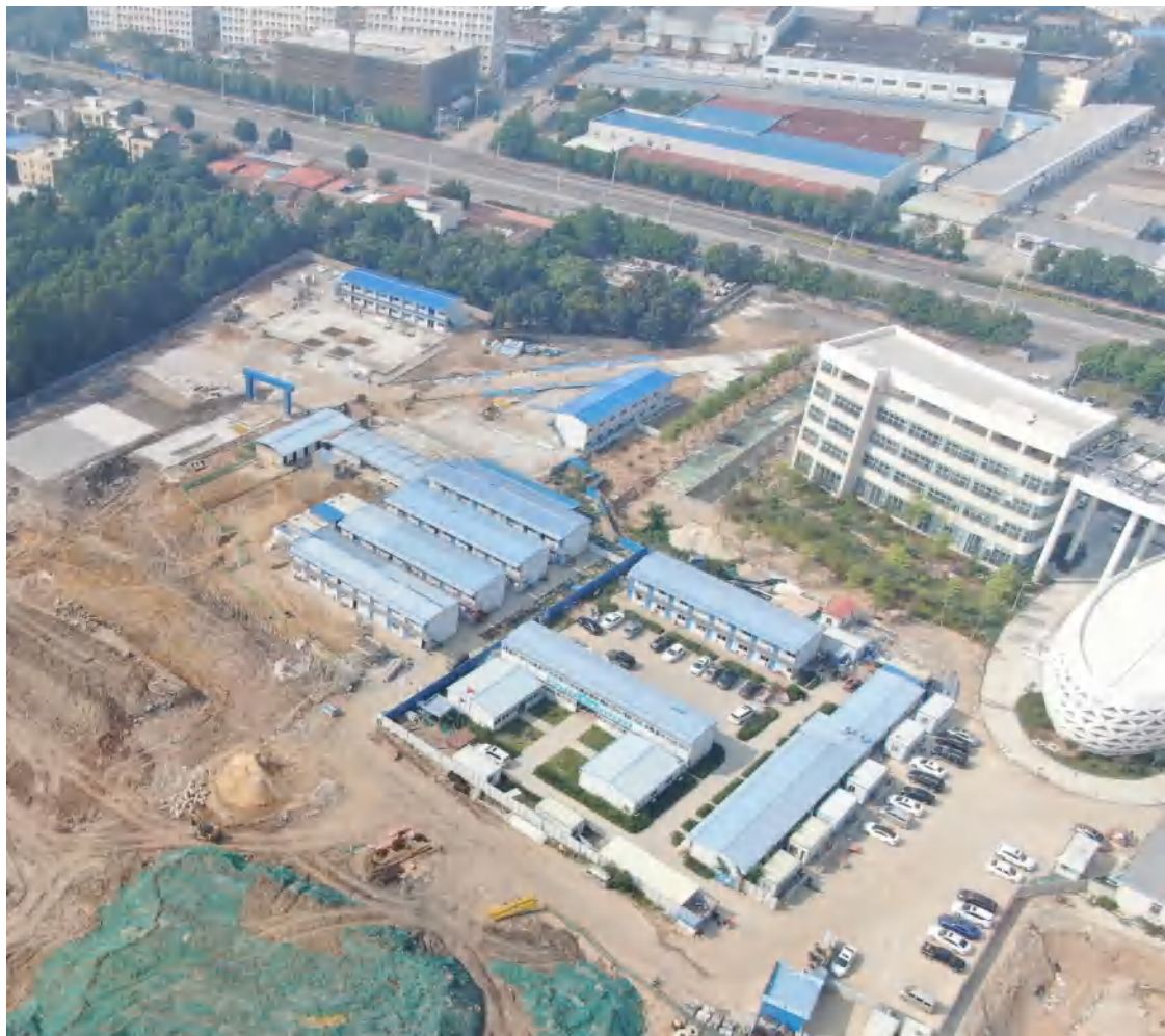
图 9 施工生产生活区
