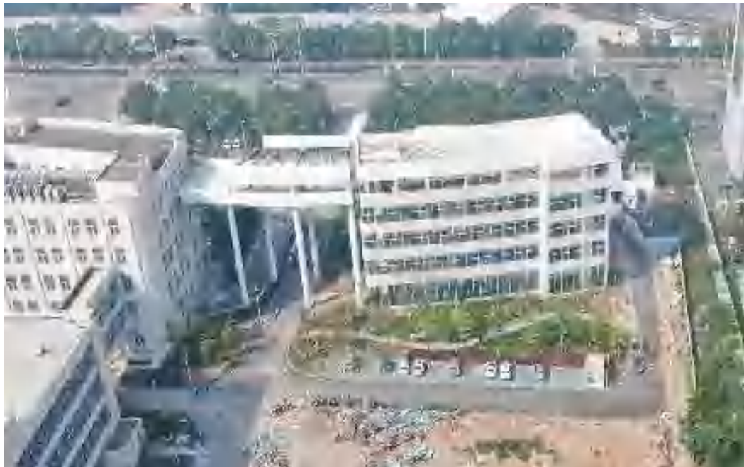
图4 东侧后勤保障楼现状
