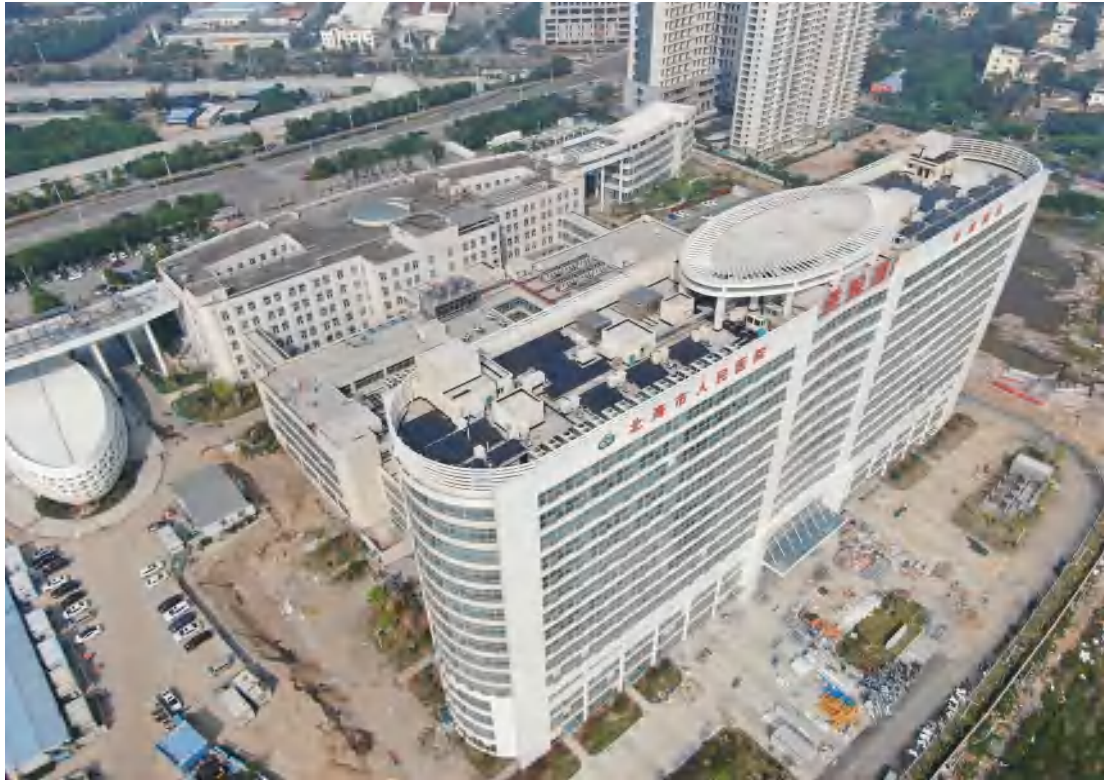
图 6 主体工程区现状
