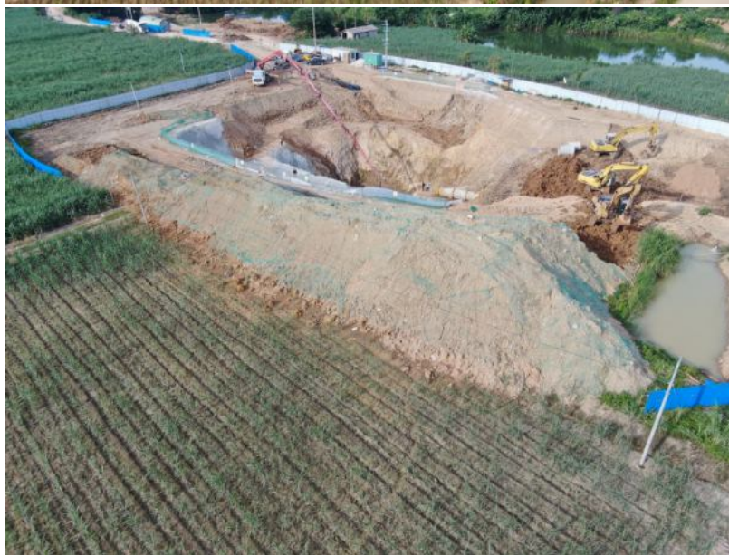
泵站施工区域西侧边界堆土监测记录图片
