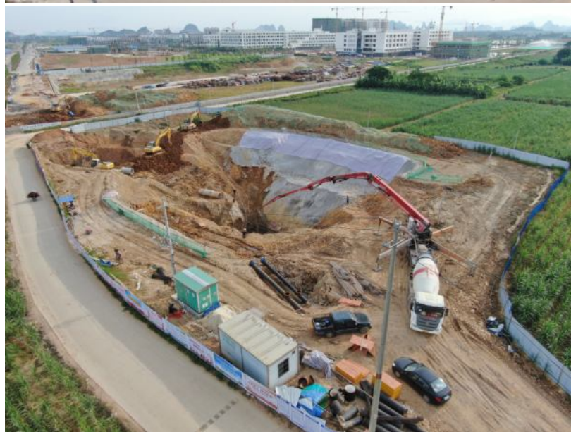
泵站施工区域防护措施布设监测记录图片
